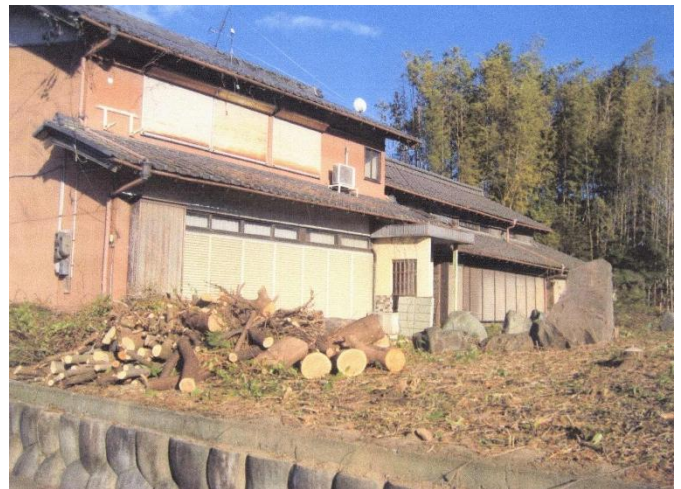
(放置空き家雑木伐採後)
